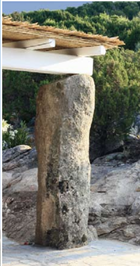
Die beim Aushub für das Becken abgetragenen Felsen wurden in die Gestaltung integriert, ob als Sichtschutz im Bereich der Dusche oder als Stütze für das Vordach im Eingangsbereich.
